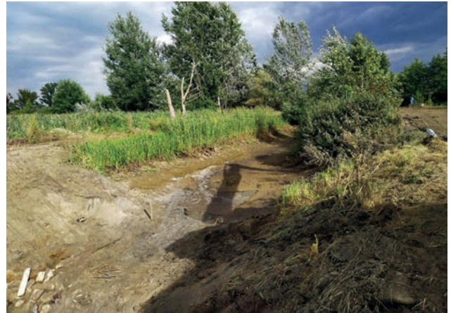
A karbantartási munkálatok miatt víztelenített Hejő-főcsatorna (Fotó: Nyeste Krisztián)
