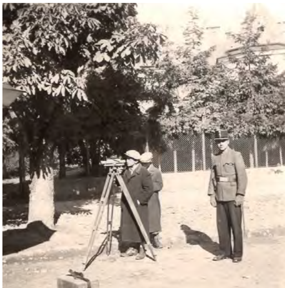
■ Bendefy László városi szintezést végez Tatán. A rendőr szünetelteti a forgalmat, amíg a műszer leolvasása tart
